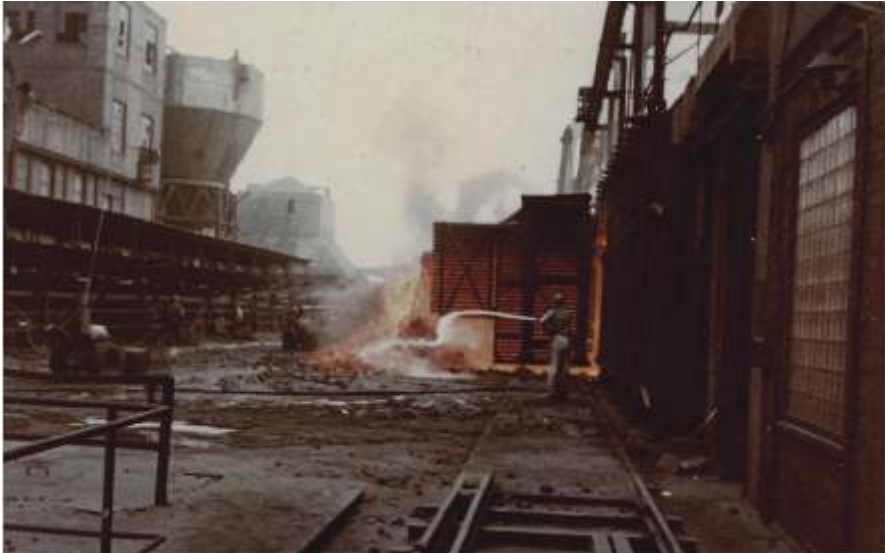
Bild 1: Kokerei Carl-Alexander 1965: Der aus den Öfen herausgedrückte Koks ist noch glühend und wird für den Weitertransport mit Wasser abgelöscht. Eine buchstäblich „heiße“ Arbeit.
